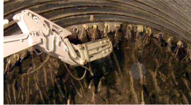
トンネル現場でのブレーカ作業は、上向きや横向きでの作業が多く、油圧ブレーカにとって極めて苛酷な作業環境です。トンネル仕様油圧ブレーカは、油圧ブレーカ本体内部に水・ダストなどが混入するのを防ぐだけでなく、油圧ショベル側にも作動油のコンタミ(有害物質による汚染)が起きないように未然に防止します。
